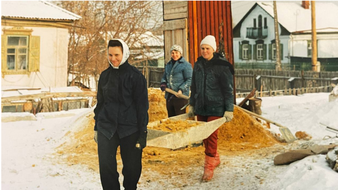
Тётушка Лидя и сёстры во Христе помогают в строительстве церкви.
